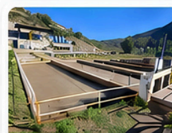
Aguas Andinas Diagnóstico Estructural Toma Independiente
